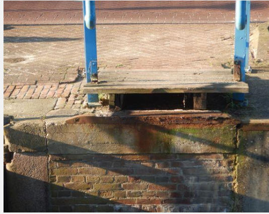
Loopbrug - Loopbrug, Algemeen
