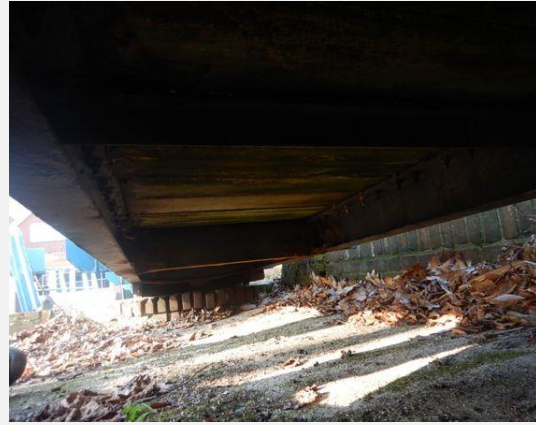
Hoofddraagconstructie - Langsligger
