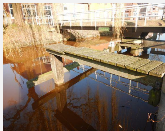
Loopbrug - Loopbrug, Algemeen
