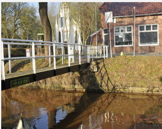
Talud - Talud, Algemeen
