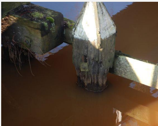
Remming- en geleidewerk - Paal
