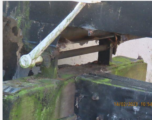
Aandrijving en bewegingswerk (mechanisch) - Assenstelsel (1)
