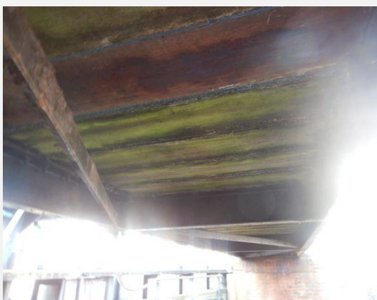
Hoofddraagconstructie - Windverband
