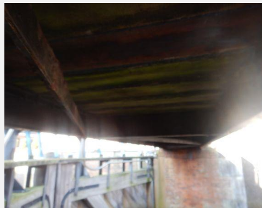
Hoofddraagconstructie - Langsligger
