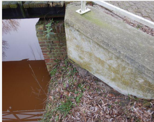
Kerende constructie - Keermuur
