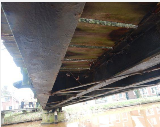
Hoofddraagconstructie - Langsligger
