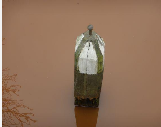
Remming- en geleidewerk - Paalbeugel
