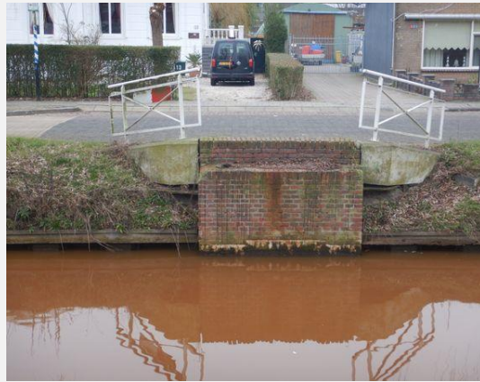
Talud - Talud, Algemeen
