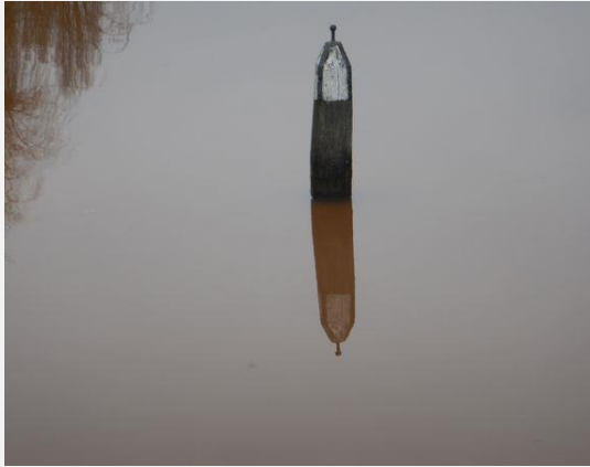
Remming- en geleidewerk - Paal
