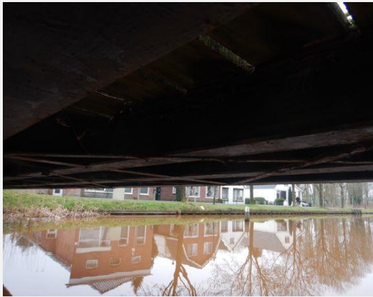
Hoofddraagconstructie - Windverband
