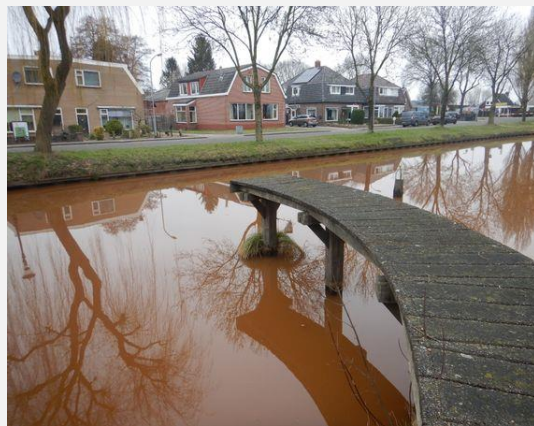
Loopbrug - Loopbrug, Algemeen
