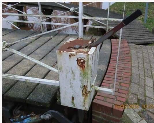
Aandrijving en bewegingswerk (elektrohydraulisch) - Kast (1)
