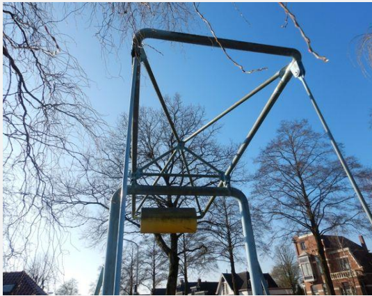
Hoofddraagconstructie (Staal) - Hangstang
