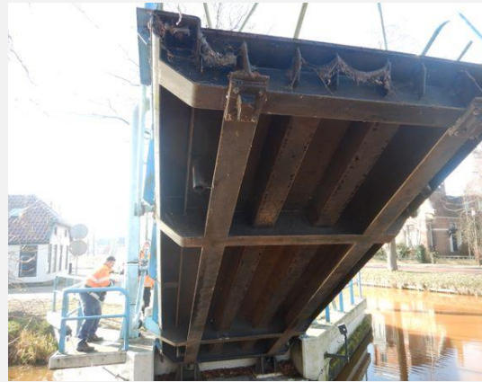
Hoofddraagconstructie (Staal) - Rijdek
