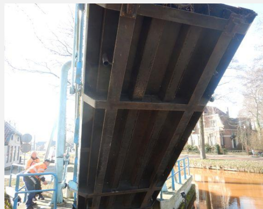
Hoofddraagconstructie (Staal) - Langsligger
