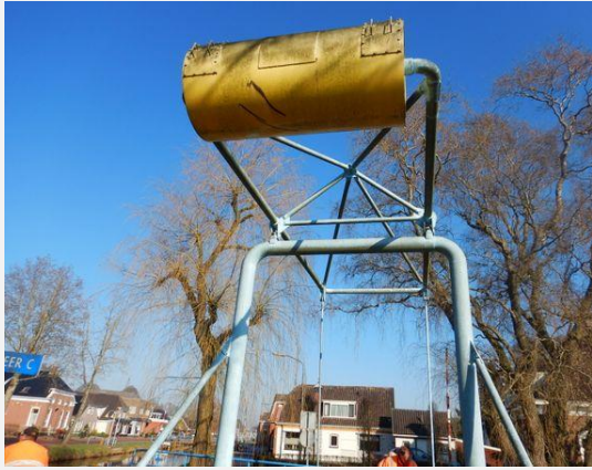
Hoofddraagconstructie (Staal) - Balanspriem
