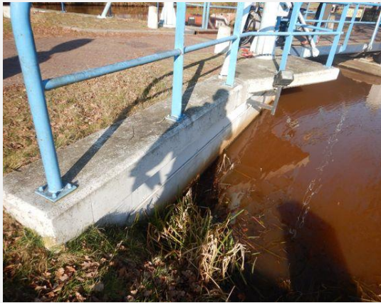
Talud - Talud, Algemeen
