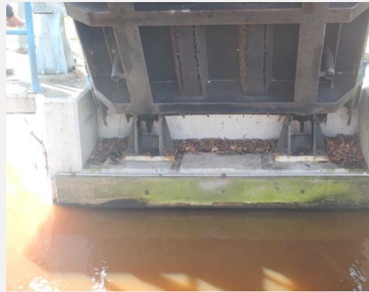
Fundering - Fundatie (Onderdeel niet zichtbaar / niet inspecteerbaar)
