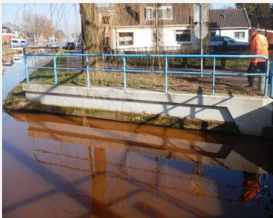
Kerende constructie - Keermuur
