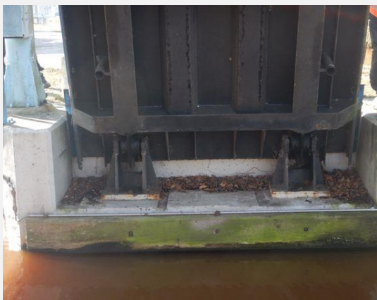
Hoofddraagconstructie (Staal) - Dwarsdrager
