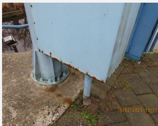
Aandrijving en bewegingswerk (elektromechanisch) - Bescherm laag (1)
