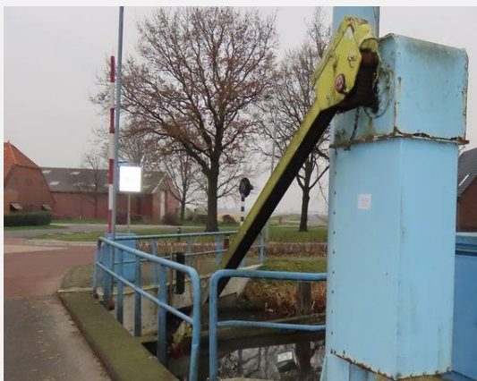
Aandrijving en bewegingswerk (elektromechanisch) - Heugelstang (1)
