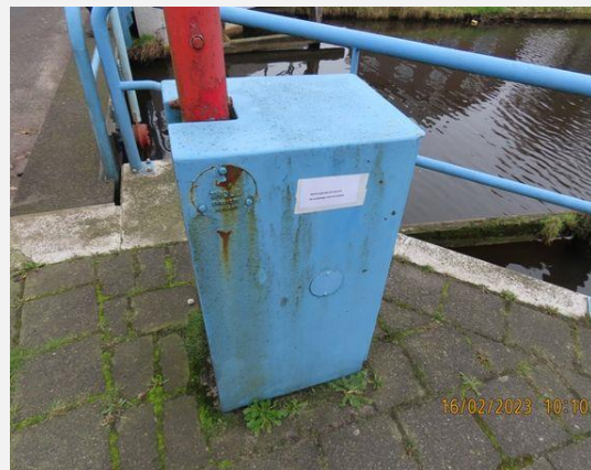
Afsluitboominstallatie - Beschermlaag (1)
