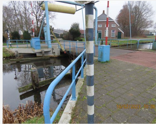
Verkeersregelinstallatie (VRI) - Mast (4 )
