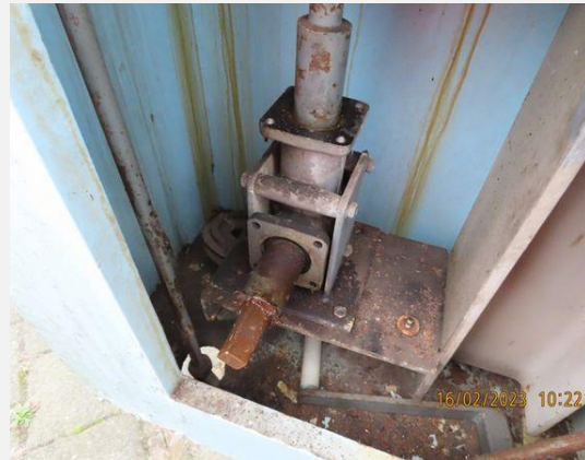
Aandrijving en bewegingswerk (elektromechanisch) - Noodhandbediening (1)
