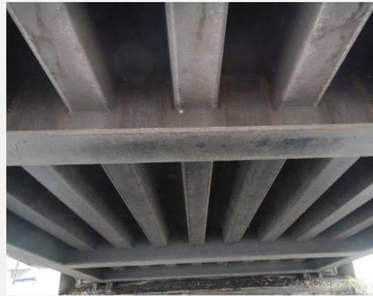
Hoofddraagconstructie (Staal) - Rijdek
