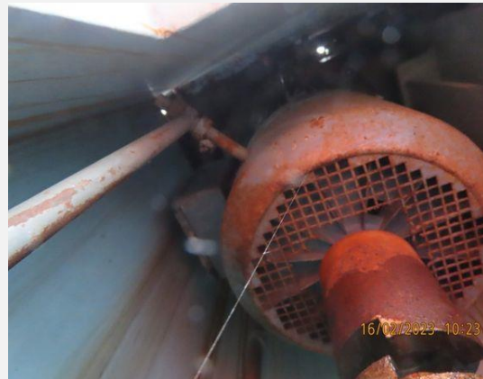
Aandrijving en bewegingswerk (elektromechanisch) - Rem (1)
