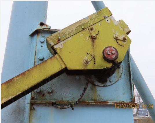
Aandrijving en bewegingswerk (elektromechanisch) - Schamelstel (1)
