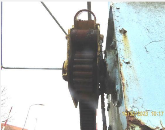
Aandrijving en bewegingswerk (elektromechanisch) - Rondsel (1)
