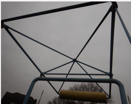
Hoofddraagconstructie (Staal) - Balanspriem
