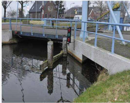
Talud - Talud, Algemeen
