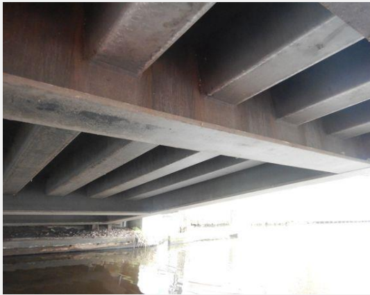
Hoofddraagconstructie (Staal) - Dwarsdrager
