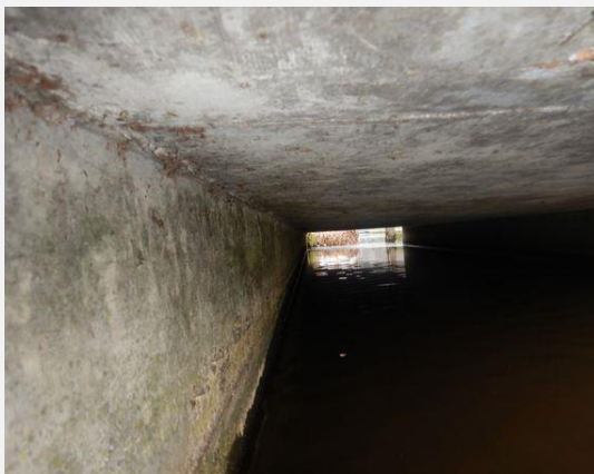
Hoofddraagconstructie (Beton) - Rijdek
