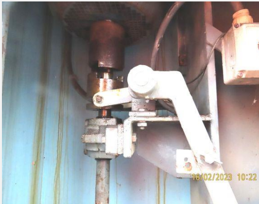
Aandrijving en bewegingswerk (elektromechanisch) - Koppeling (2)
