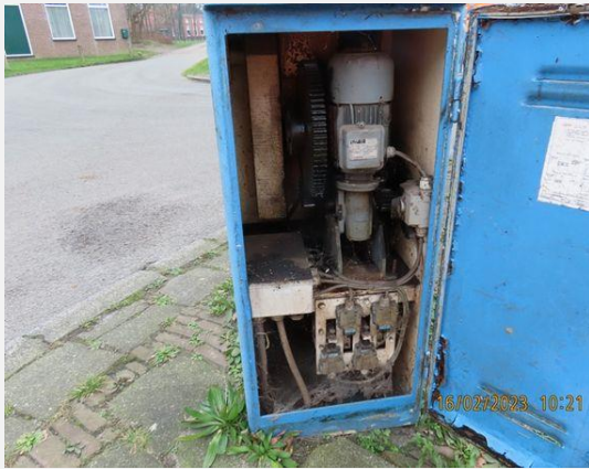
Afsluitboominstallatie - Aandrijving (4)
