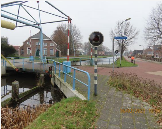
Verkeersregelinstallatie (VRI) - Landverkeerssein (4 )
