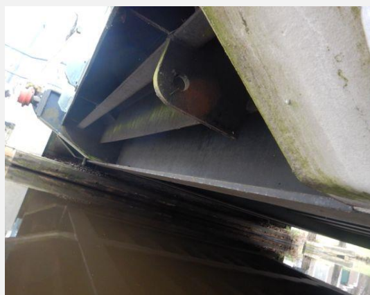
Hoofddraagconstructie (Staal) - Langsligger
