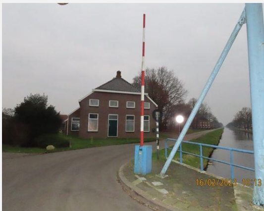
Afsluitboominstallatie - Afsluitboominstallatie, Algemeen (4)
