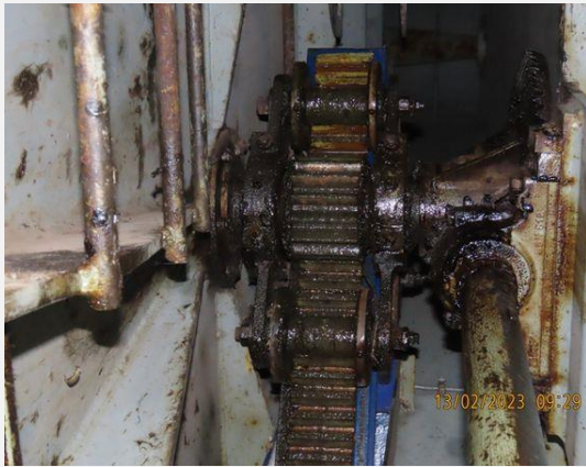
Aandrijving en bewegingswerk (elektromechanisch) - Rondsel (1)
