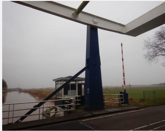
Hoofddraagconstructie (Staal) - Hameistijl (-poort) (2 stuk(s))
