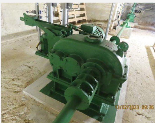
Aandrijving en bewegingswerk (elektromechanisch) - Reductiekast (3)
