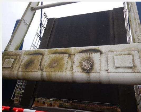
Hoofddraagconstructie (Staal) - Contragewicht (1 stuk(s))
