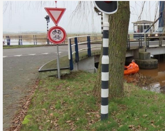
Verkeersregelinstallatie (VRI) - Beschermlaag (7 )
