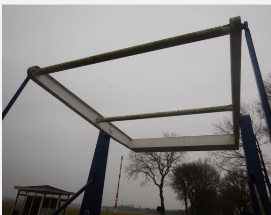
Hoofddraagconstructie (Staal) - Hangstang (2 stuk(s))
