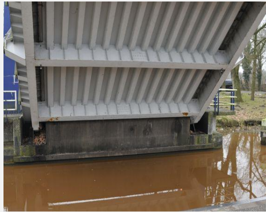
Hoofddraagconstructie (Staal) - Dwarsdrager
