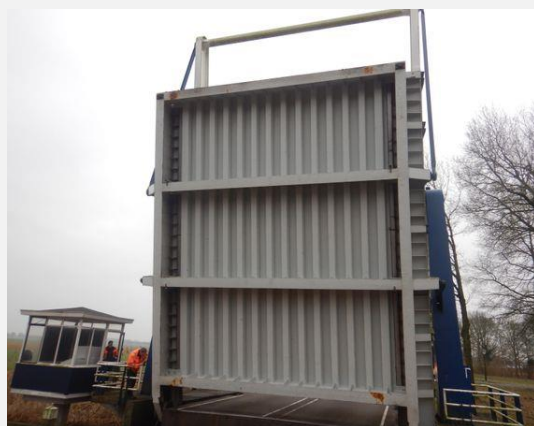
Hoofddraagconstructie (Staal) - Rijdek
