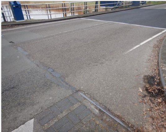
Verharding wegtype 2 (zwaarbelaste weg) - Deklaag (dicht)
