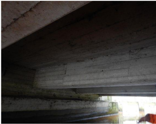
Hoofddraagconstructie (Beton) - Langsligger
