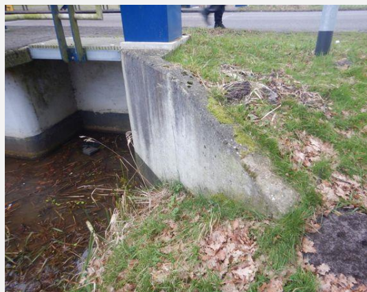
Kerende constructie - Vleugelwand
