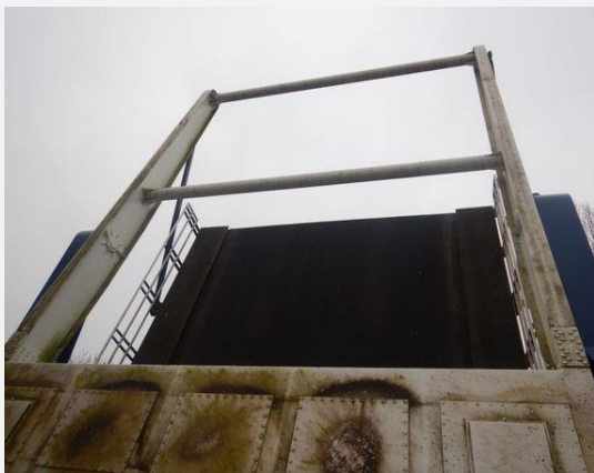
Hoofddraagconstructie (Staal) - Balanspriem (2 stuk(s))
