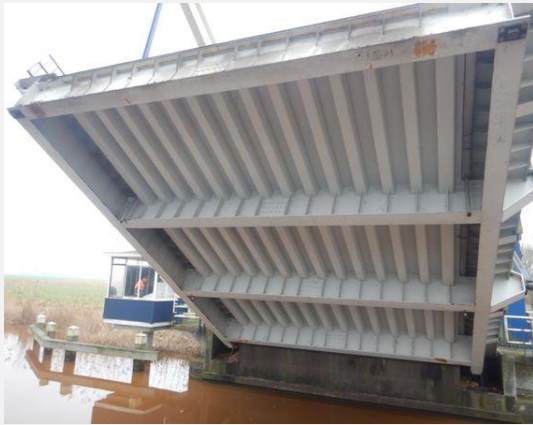
Hoofddraagconstructie (Staal) - Langsligger
