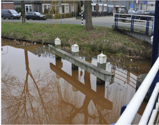
Remming- en geleidewerk - Paal
