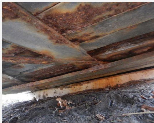
Hoofddraagconstructie - Windverband
