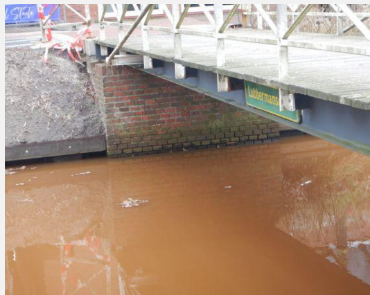
Fundering - Fundatie (Onderdeel niet zichtbaar / niet inspecteerbaar)
