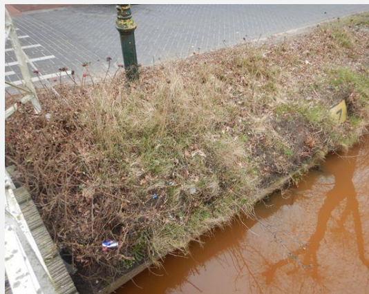
Talud - Talud, Algemeen
