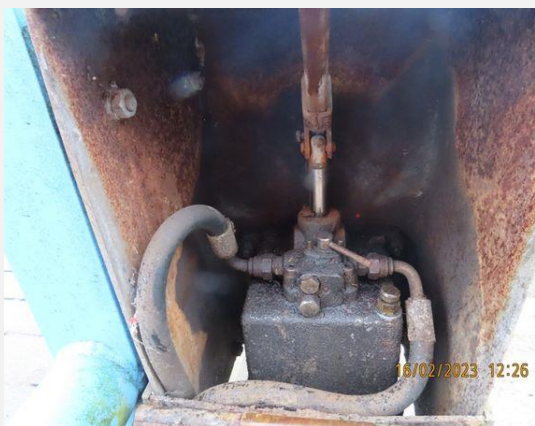
Aandrijving en bewegingswerk (elektrohydraulisch) - Hydraulisch aggregaat (1)
