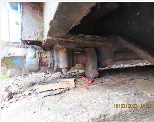
Aandrijving en bewegingswerk (elektrohydraulisch) - Draaipunt (6)
