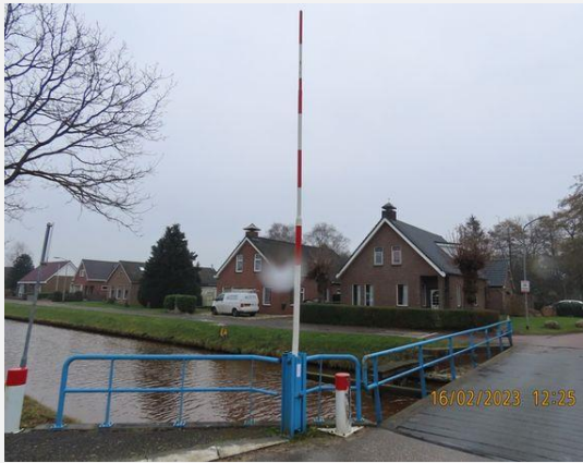
Afsluitboominstallatie - Afsluitboominstallatie, Algemeen (2)
