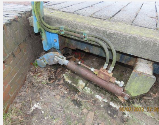
Aandrijving en bewegingswerk (elektrohydraulisch) - Cilinder (1)
