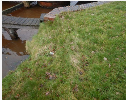
Talud - Talud, Algemeen
