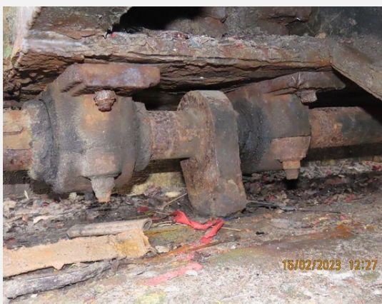
Aandrijving en bewegingswerk (elektrohydraulisch) - Opzetinrichting (2)
