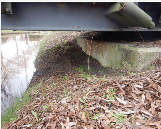
Fundering - Fundatie (Onderdeel niet zichtbaar / niet inspecteerbaar)
