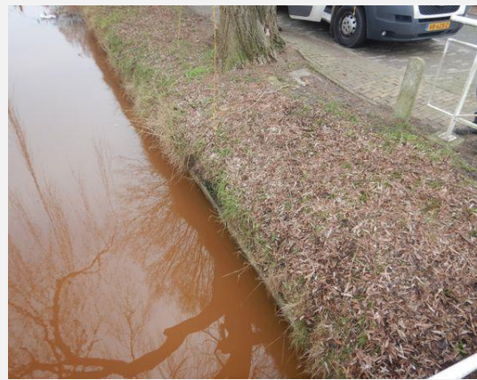
Talud - Talud, Algemeen
