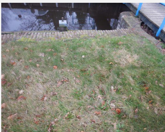
Talud - Talud, Algemeen
