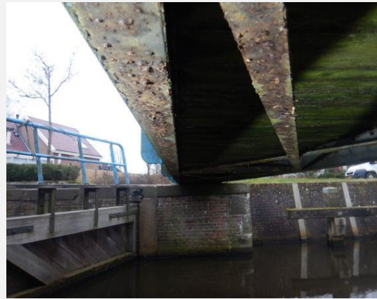
Hoofddraagconstructie - Langsligger
