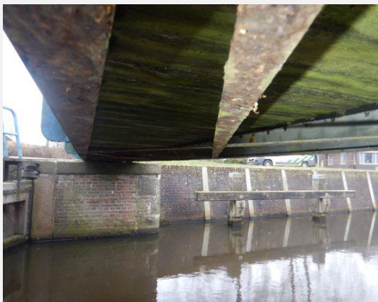
Hoofddraagconstructie - Windverband
