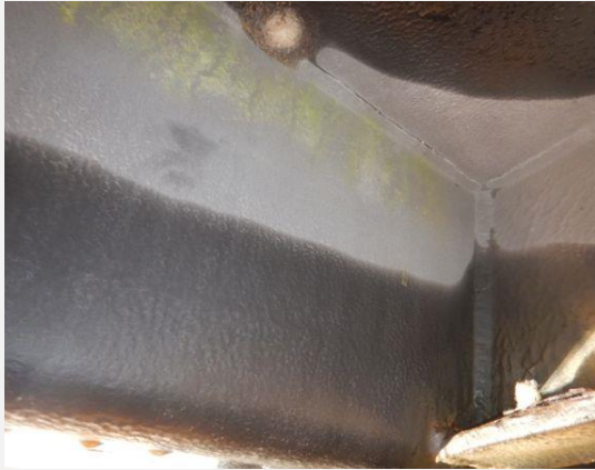
Hoofddraagconstructie (Staal) - Rijdek
