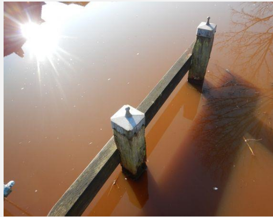
Remming- en geleidewerk - Paal
