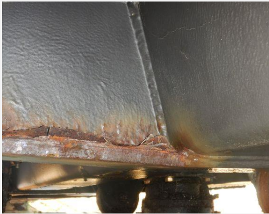
Hoofddraagconstructie (Staal) - Beschermlaag
