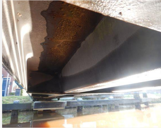
Hoofddraagconstructie (Staal) - Langsligger
