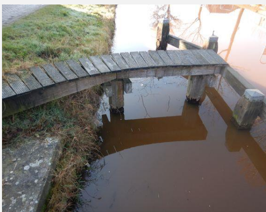
Loopbrug - Loopbrug, Algemeen
