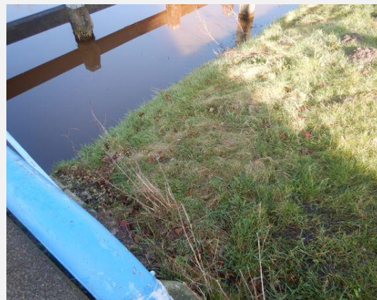
Talud - Talud, Algemeen
