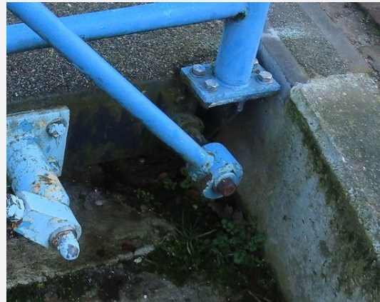
Aandrijving en bewegingswerk (mechanisch) - Draaipunt (4)
