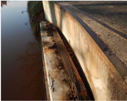
Fundering - Fundatie (Onderdeel niet zichtbaar / niet inspecteerbaar)
