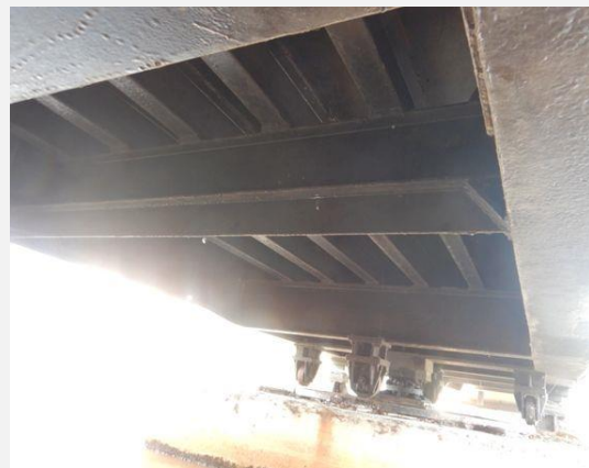
Hoofddraagconstructie - Dwarsdrager
