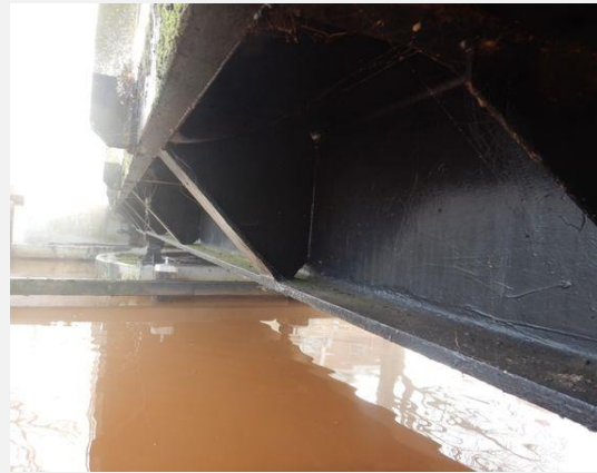
Hoofddraagconstructie - Beschermlaag
