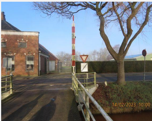
Afsluitboominstallatie - Afsluitboominstallatie, Algemeen (2)
