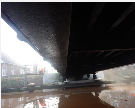
Hoofddraagconstructie - Langsligger
