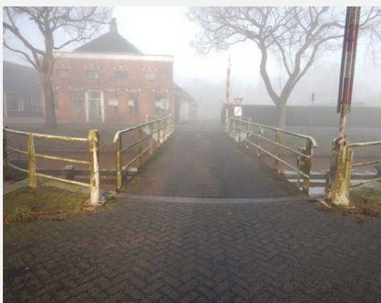
Verharding wegtype 4 (licht belast) - Elementenverharding
