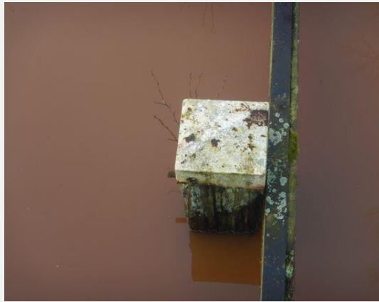
Remming- en geleidewerk - Paal
