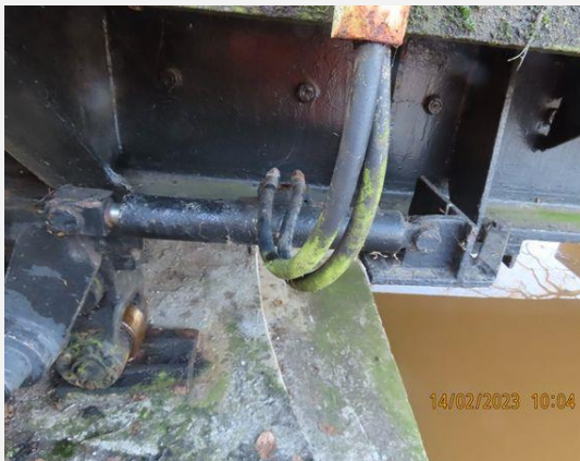
Aandrijving en bewegingswerk (elektrohydraulisch) - Buisleiding (2)
