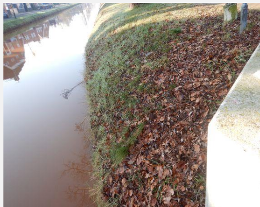
Talud - Talud, Algemeen
