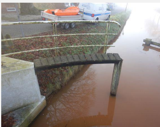
Loopbrug - Loopbrug, Algemeen
