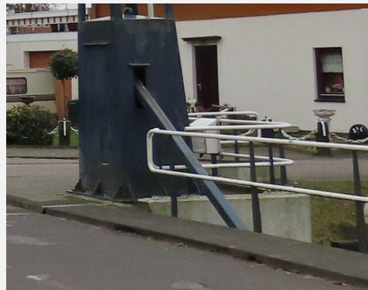
Aandrijving en bewegingswerk (mechanisch) - Heugelstang (1)
