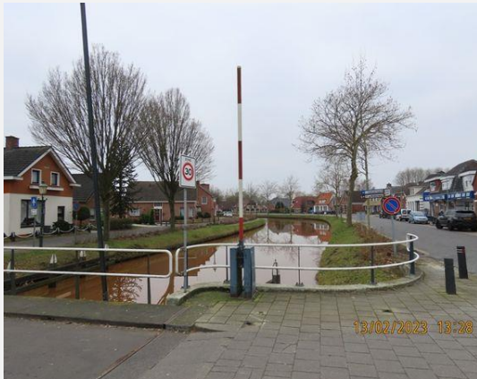
Afsluitboominstallatie - Afsluitboominstallatie, Algemeen (4)
