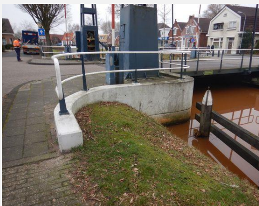
Talud - Talud, Algemeen
