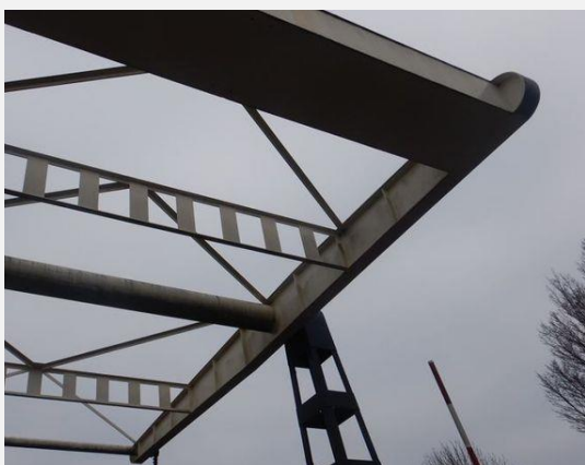
Hoofddraagconstructie (Staal) - Balanspriem
