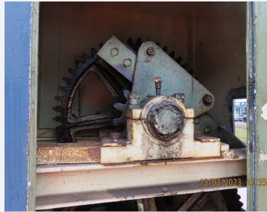
Aandrijving en bewegingswerk (mechanisch) - Schamelstel (1)
