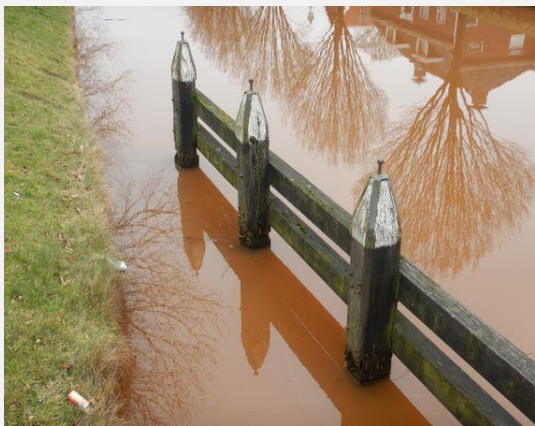
Remming- en geleidewerk - Paal
