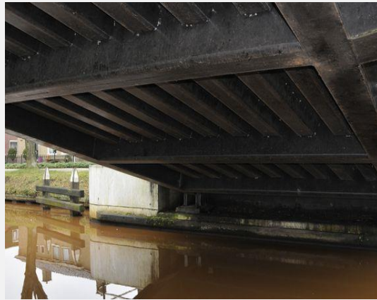
Hoofddraagconstructie (Staal) - Rijdek
