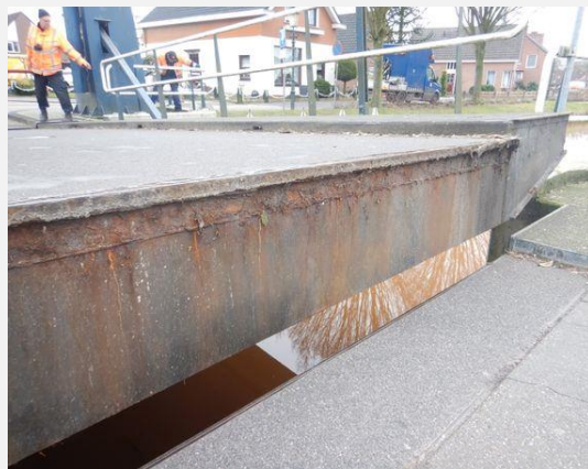
Hoofddraagconstructie (Staal) - Dwarsdrager
