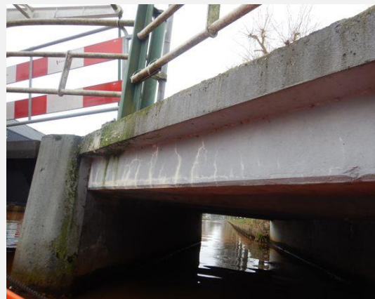
Hoofddraagconstructie (Beton) - Langsligger
