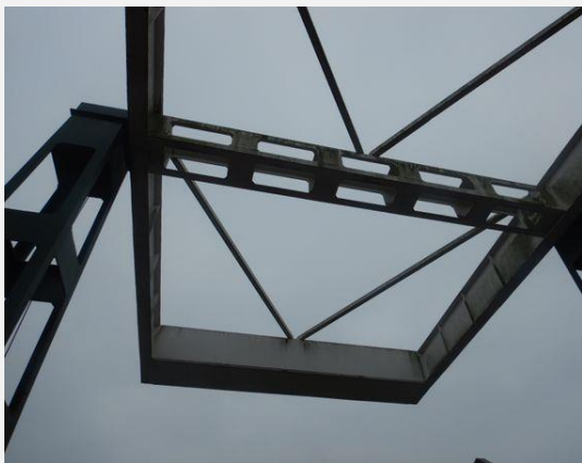
Hoofddraagconstructie (Staal) - Diagonaal (vakwerkligger)
