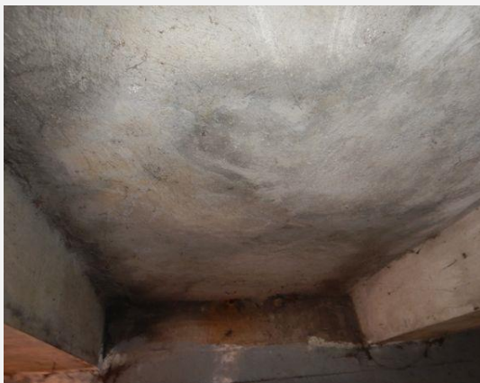
Hoofddraagconstructie (Beton) - Rijdek
