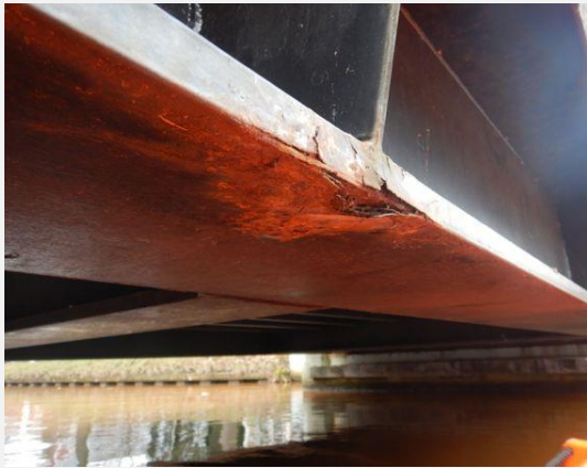
Hoofddraagconstructie (Staal) - Langsligger
