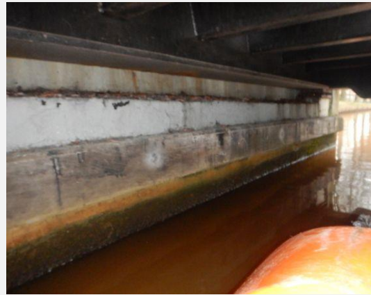
Hoofddraagconstructie (Staal) - Dwarsdrager
