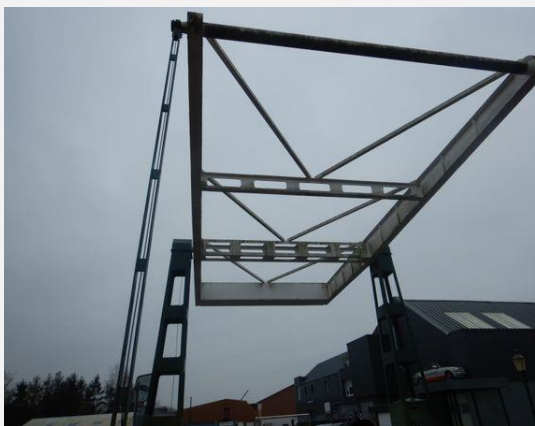
Hoofddraagconstructie (Staal) - Hangstang
