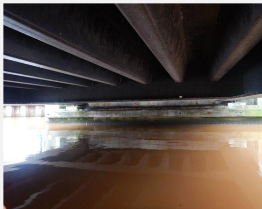
Hoofddraagconstructie (Staal) - Rijdek
