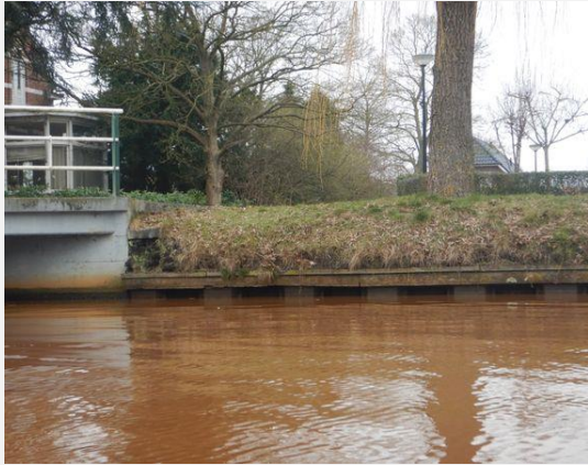
Talud - Talud, Algemeen
