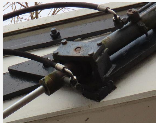
Aandrijving en bewegingswerk (elektrohydraulisch) - Draaipunt (4)
