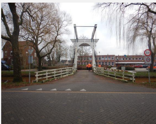
Verharding wegtype 4 (licht belast) - Elementenverharding
