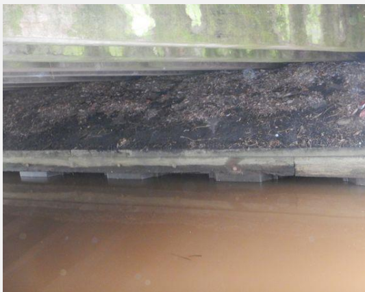
Fundering - Fundatie (Onderdeel niet zichtbaar / niet inspecteerbaar)
