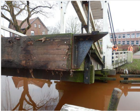
Hoofddraagconstructie - Console
