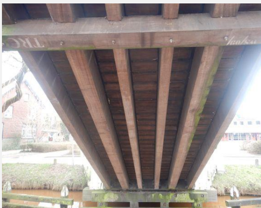
Hoofddraagconstructie - Langsligger
