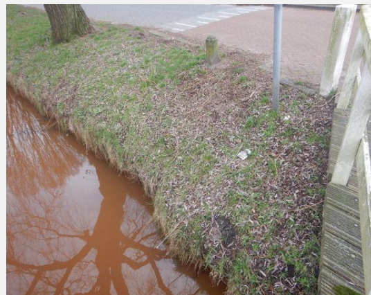
Talud - Talud, Algemeen
