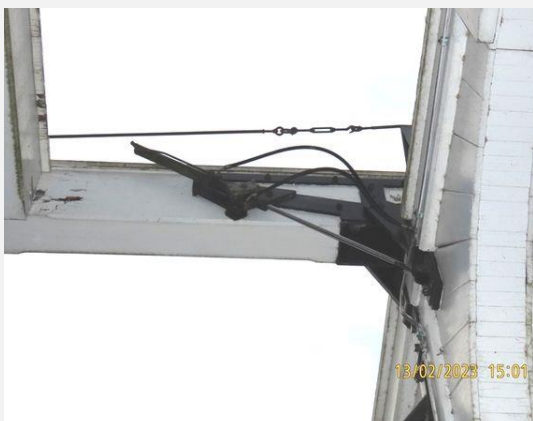
Aandrijving en bewegingswerk (elektrohydraulisch) - Cilinder (2)
