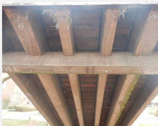
Hoofddraagconstructie - Dwarsdrager
