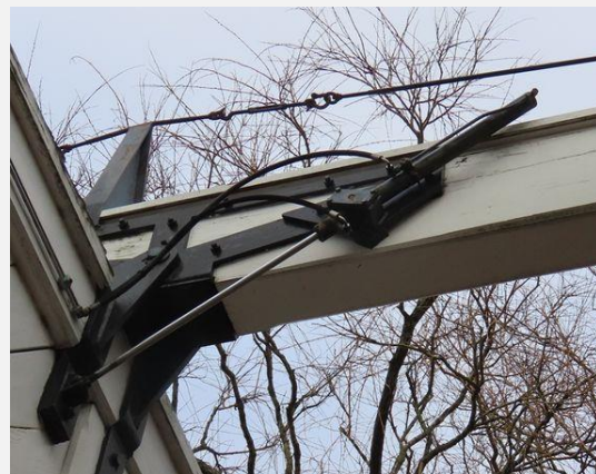
Aandrijving en bewegingswerk (elektrohydraulisch) - Beschermlaag ( 1 )
