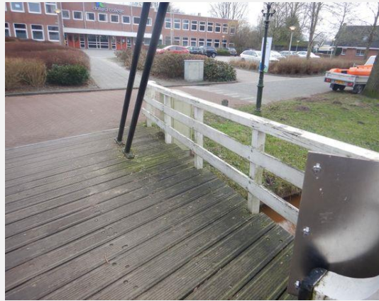
Hoofddraagconstructie - Hangstang
