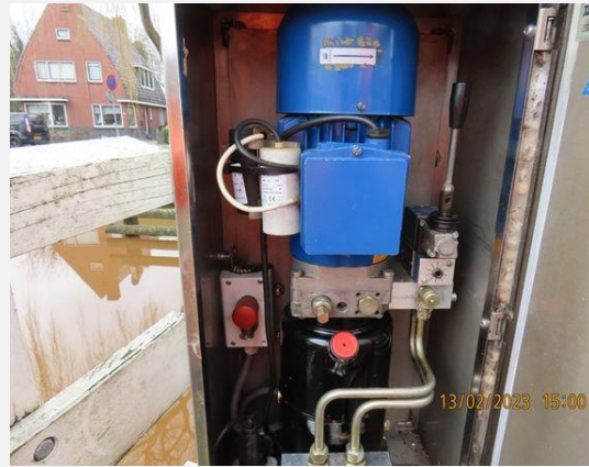
Aandrijving en bewegingswerk (elektrohydraulisch) - Hydraulisch aggregaat ( 1 )
