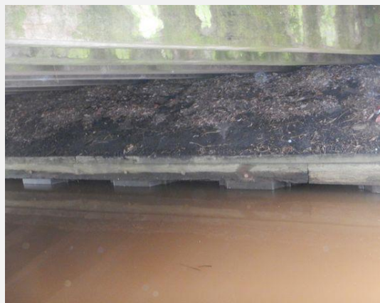
Kerende constructie - Damwand
