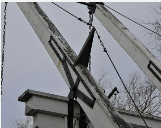
Hoofddraagconstructie - Balanspriem
