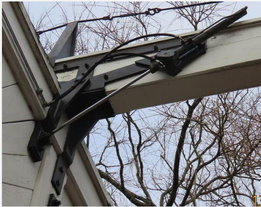
Aandrijving en bewegingswerk (elektrohydraulisch) - Frame ( 2 )
