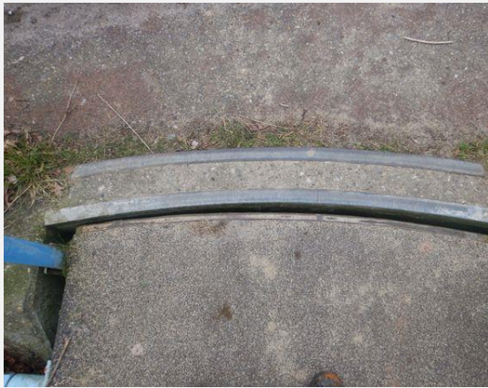
Voegovergang - Beëindigingsprofiel
