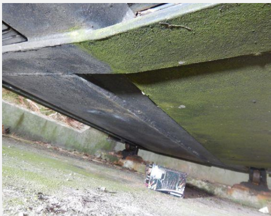
Hoofddraagconstructie (Staal) - Dwarsdrager
