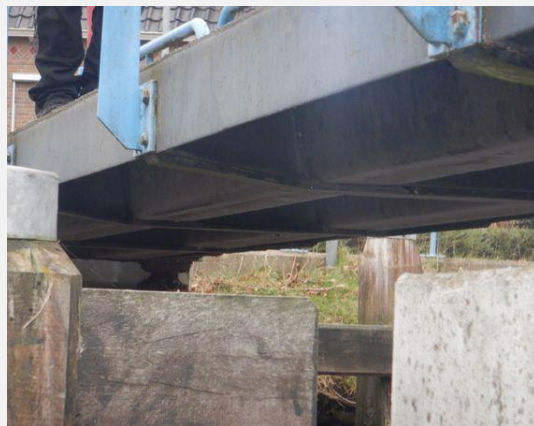
Hoofddraagconstructie (Staal) - Langsligger
