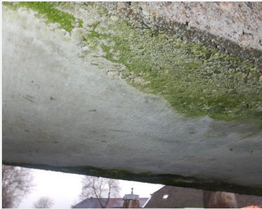
Hoofddraagconstructie (Beton) - Rijdek
