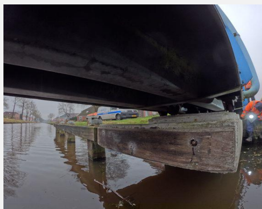
Hoofddraagconstructie (Staal) - Rijdek
