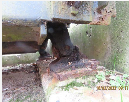
Aandrijving en bewegingswerk (mechanisch) - Frame (1)
