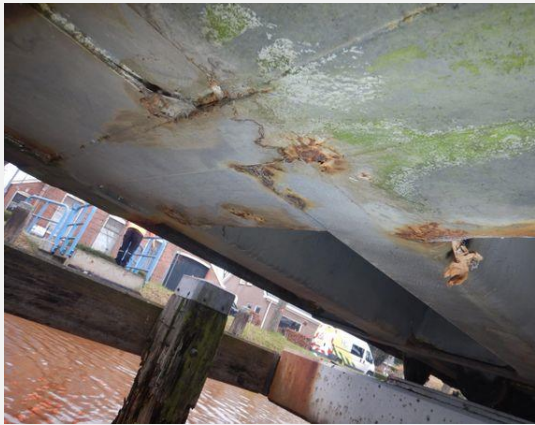
Hoofddraagconstructie (Staal) - Rijdek
