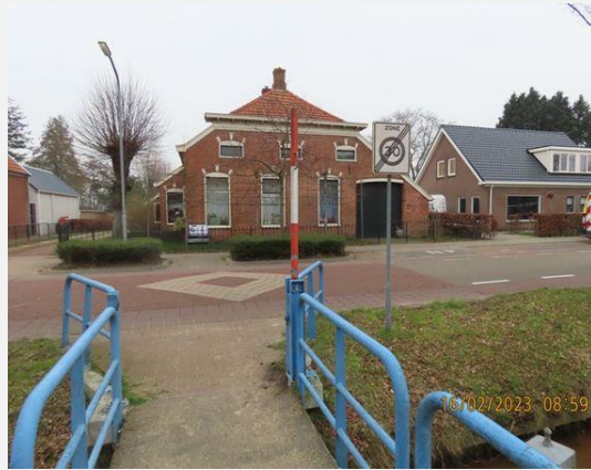
Afsluitboominstallatie - Afsluitboominstallatie, Algemeen (2)
