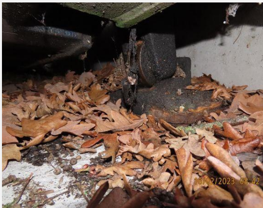
Aandrijving en bewegingswerk (mechanisch) - Opzetinrichting (2)
