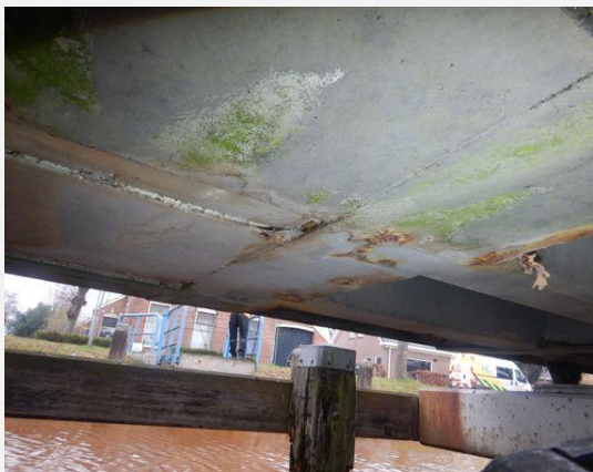
Hoofddraagconstructie (Staal) - Dwarsdrager
