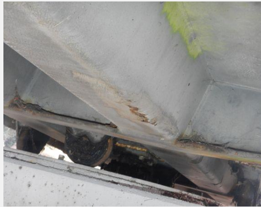
Hoofddraagconstructie (Staal) - Langsligger
