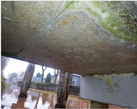
Hoofddraagconstructie (Beton) - Rijdek
