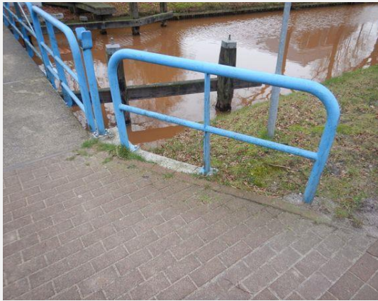
Talud - Talud, Algemeen
