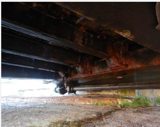
Hoofddraagconstructie (Staal) - Langsligger
