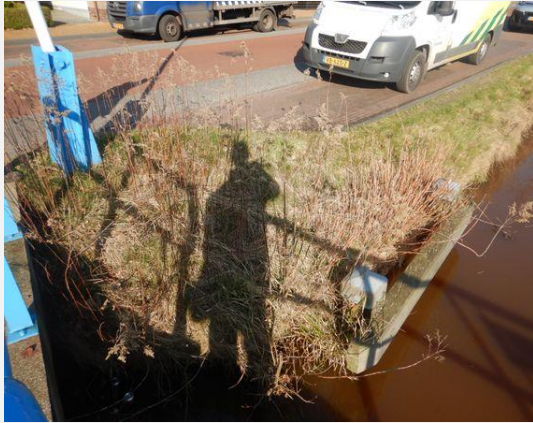
Talud - Talud, Algemeen
