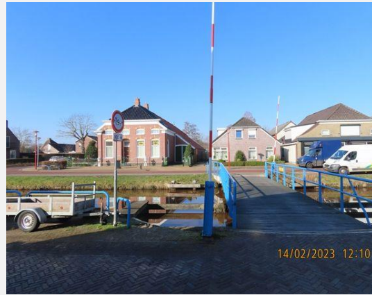
Afsluitboominstallatie - Afsluitboominstallatie, Algemeen (2)
