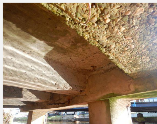
Hoofddraagconstructie (Beton) - Rijdek
