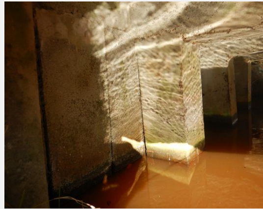
Kerende constructie - Damwand
