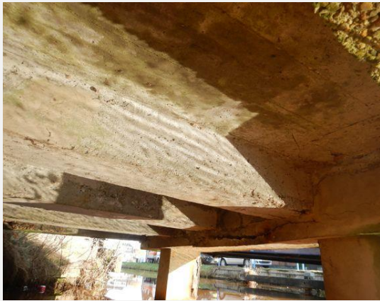
Hoofddraagconstructie (Beton) - Langsligger
