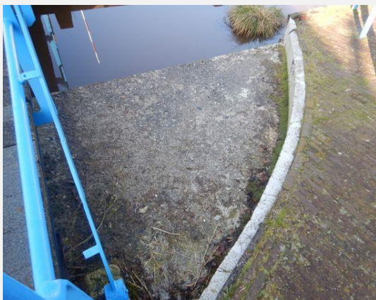
Kerende constructie - Keermuur
