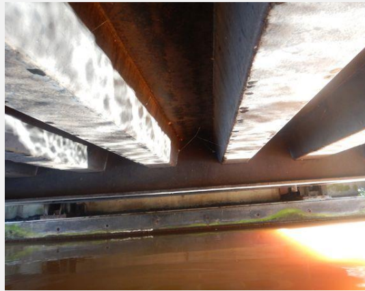
Hoofddraagconstructie (Staal) - Rijdek
