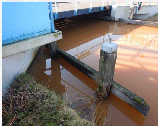
Remming- en geleidewerk - Paal
