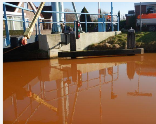
Fundering - Fundatie (Onderdeel niet zichtbaar / niet inspecteerbaar)
