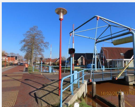
Verkeersregelinstallatie (VRI) - Landverkeerssein (4)
