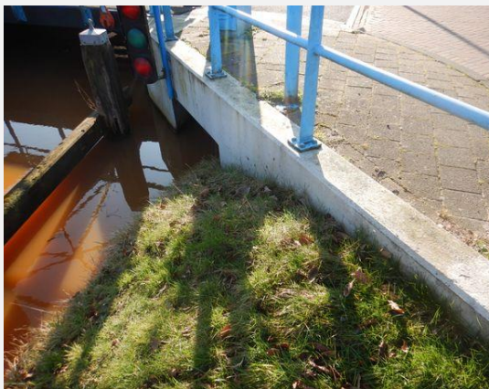
Talud - Talud, Algemeen
