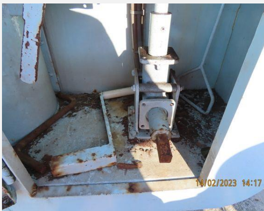
Aandrijving en bewegingswerk (elektromechanisch) - Noodhandbediening (1)
