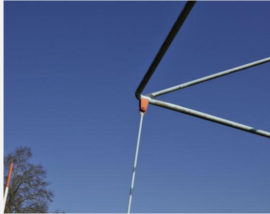
Hoofddraagconstructie (Staal) - Hangstang
