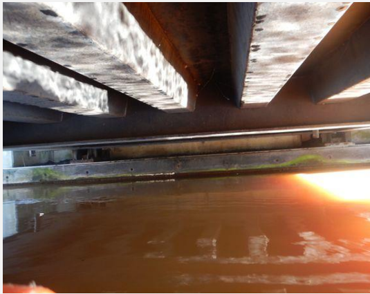
Hoofddraagconstructie (Staal) - Langsligger
