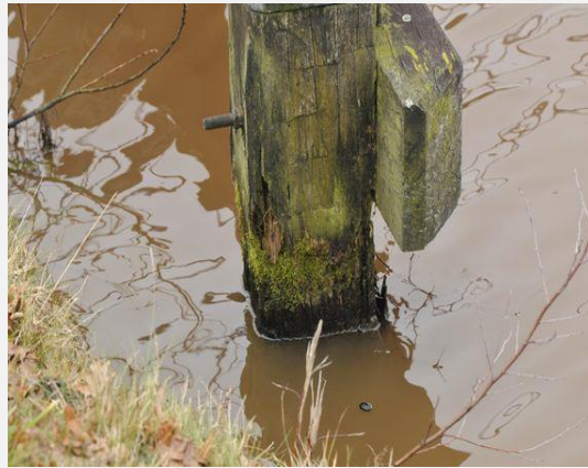
Remming- en geleidewerk - Paal
