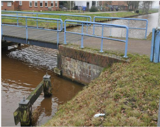
Talud - Talud, Algemeen
