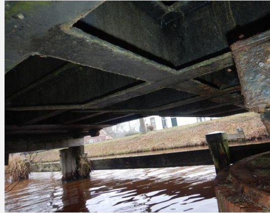
Hoofddraagconstructie - Dwarsdrager
