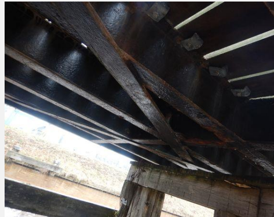
Hoofddraagconstructie - Windverband
