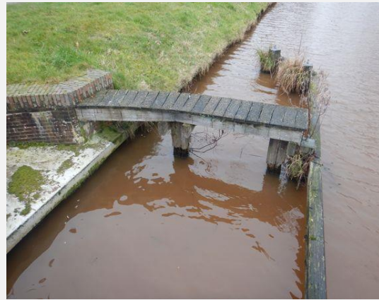
Loopbrug - Loopbrug, Algemeen
