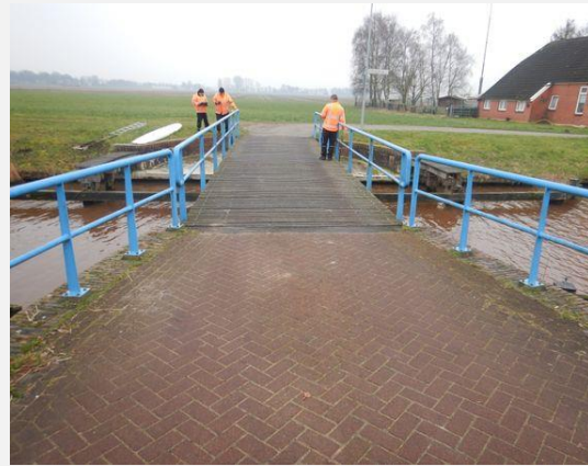
Verharding wegtype 4 (licht belast) - Elementenverharding
