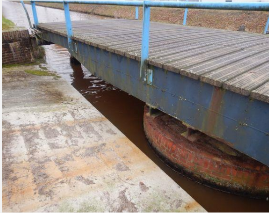
Hoofddraagconstructie - Bescherm laag
