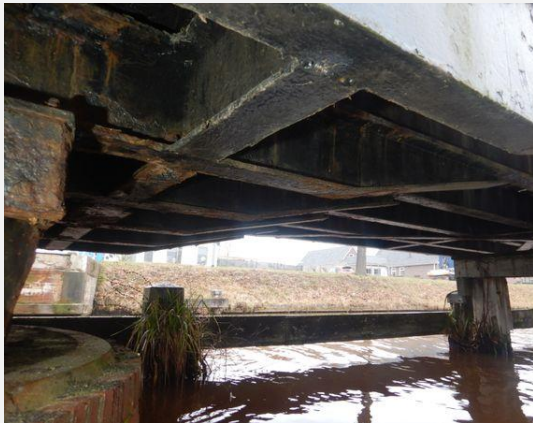
Hoofddraagconstructie - Langsligger
