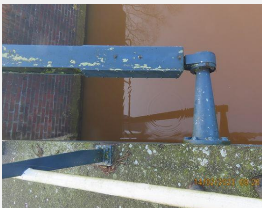
Aandrijving en bewegingswerk (elektromechanisch) - Buffer (2)
