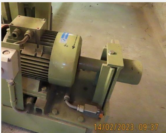
Aandrijving en bewegingswerk (elektromechanisch) - Noodhandbediening (1)
