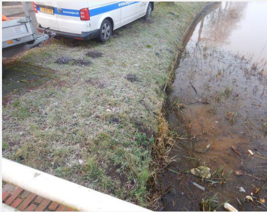
Talud - Talud, Algemeen
