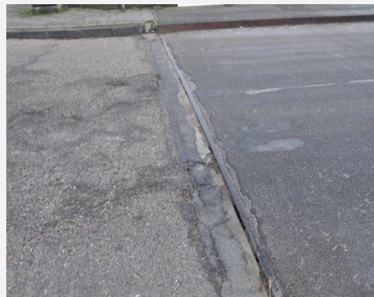
Voegovergang - Beëindigingsprofiel
