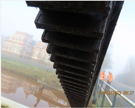
Aandrijving en bewegingswerk (elektromechanisch) - Heugelstang (2)
