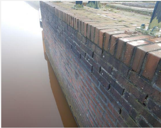
Kerende constructie - Wand
