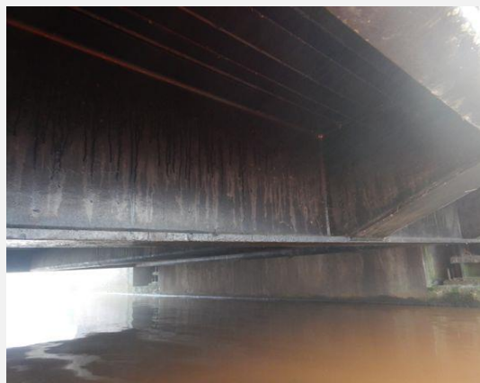
Hoofddraagconstructie - Langsligger
