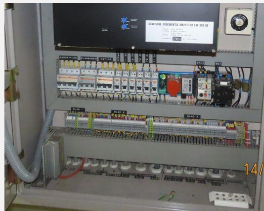
Laagspanningsinstallatie - Onderverdeler (1)
