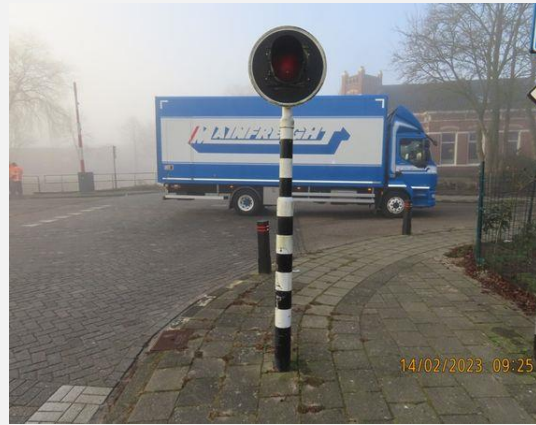
Verkeersregelinstallatie (VRI) - Mast (6 )
