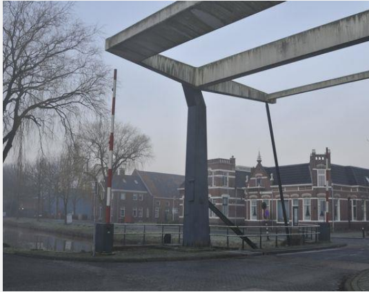
Hoofddraagconstructie - Balanspriem
